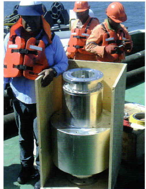
Preparación para instalación de NTS®-PU 8" submarino en Paíta, Perú de la empresa Haug
